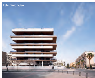
Residencial Tridente: 34 viviendas en Alicante
