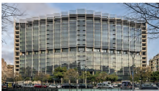
Edificio Estel, Barcelona
